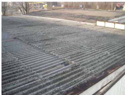
Figura 3.3 – :Stato di conservazione della copertura dei laboratori e della pesa
