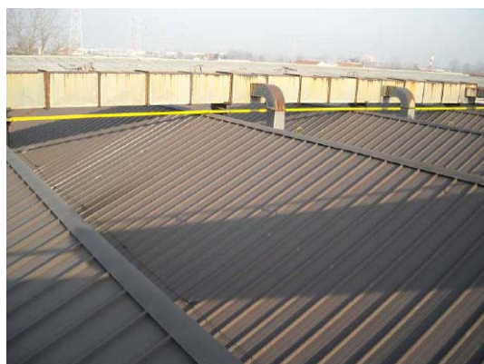
Figura 3.4 – Stato di conservazione della copertura dei reparti di impregnazione (porzione)
