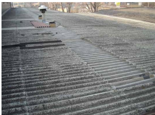
Figura 3.3 – :Stato di conservazione della copertura dei laboratori e della pesa
