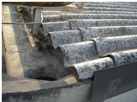
Figura 3.6 – Stato di conservazione della copertura del magazzino della carta fenolica e di collaudo CPL
