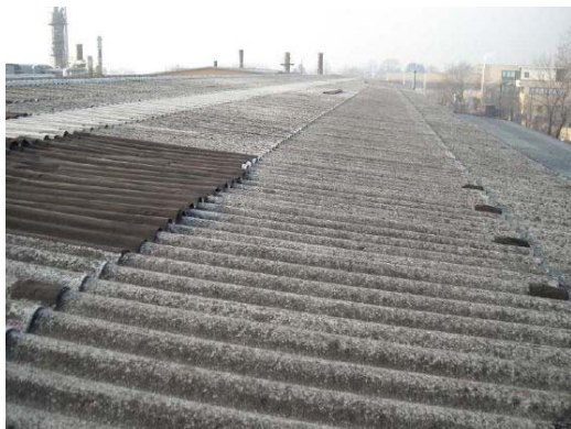
Figura 3.7 – Stato di conservazione della copertura del magazzino spedizioni
